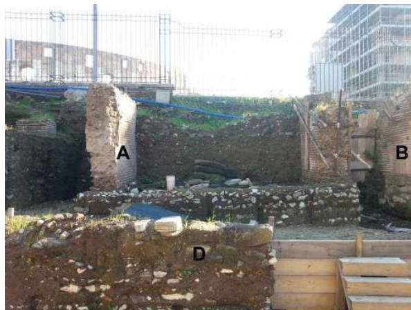
Fig. 26 - La fondazione neroniana nord-sud (D) immediatamente a ovest del tempietto flavio, sullo sfondo i resti di quest'ultimo e a destra il muro di età antonina.
