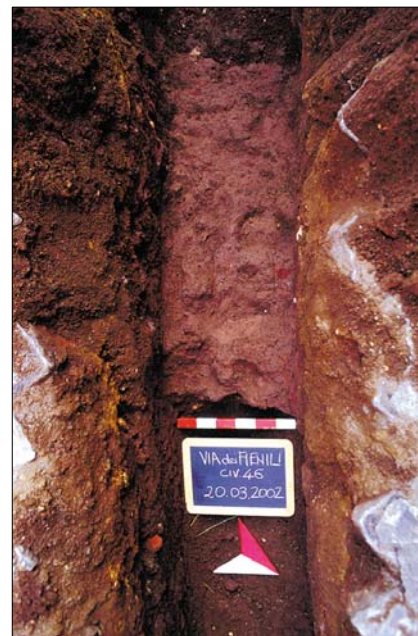
Fig. 12. Via dei Fienili 46. Struttura in cementizio d'incerta interpretazione, forse fognatura o fondazione (foto di O. Menghi).
