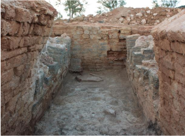
Fig. 4. Dettaglio costruttivo del restauro nella camera di combustione della fornace 1. Si vedono il muro di fondo e i piani d'imposta degli archi in mattoni crudi.
