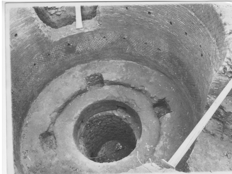
Fig. 17. Castellum aquae via di Torre Rossa, 35 – fotografia (SITAR, OI 1073).
