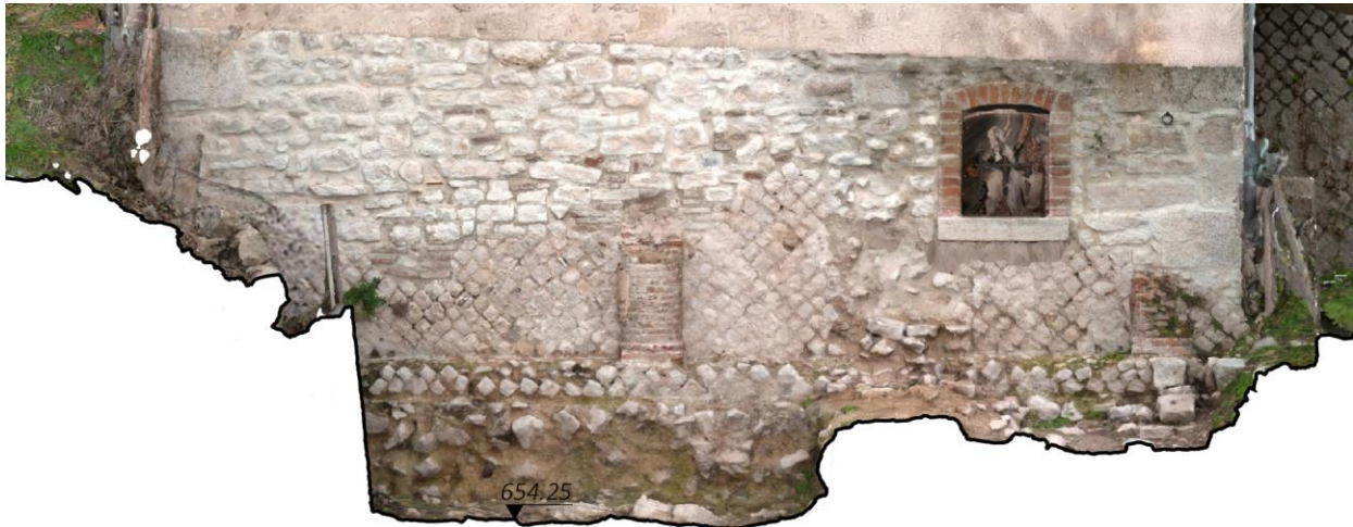
Fig. 11. Prospetto del muro in opera reticolata con semicolonne in cotto (immagine acquisita e rielaborata da LabGraf3D s.r.l. ed estrapolata da M. Notardonato).
