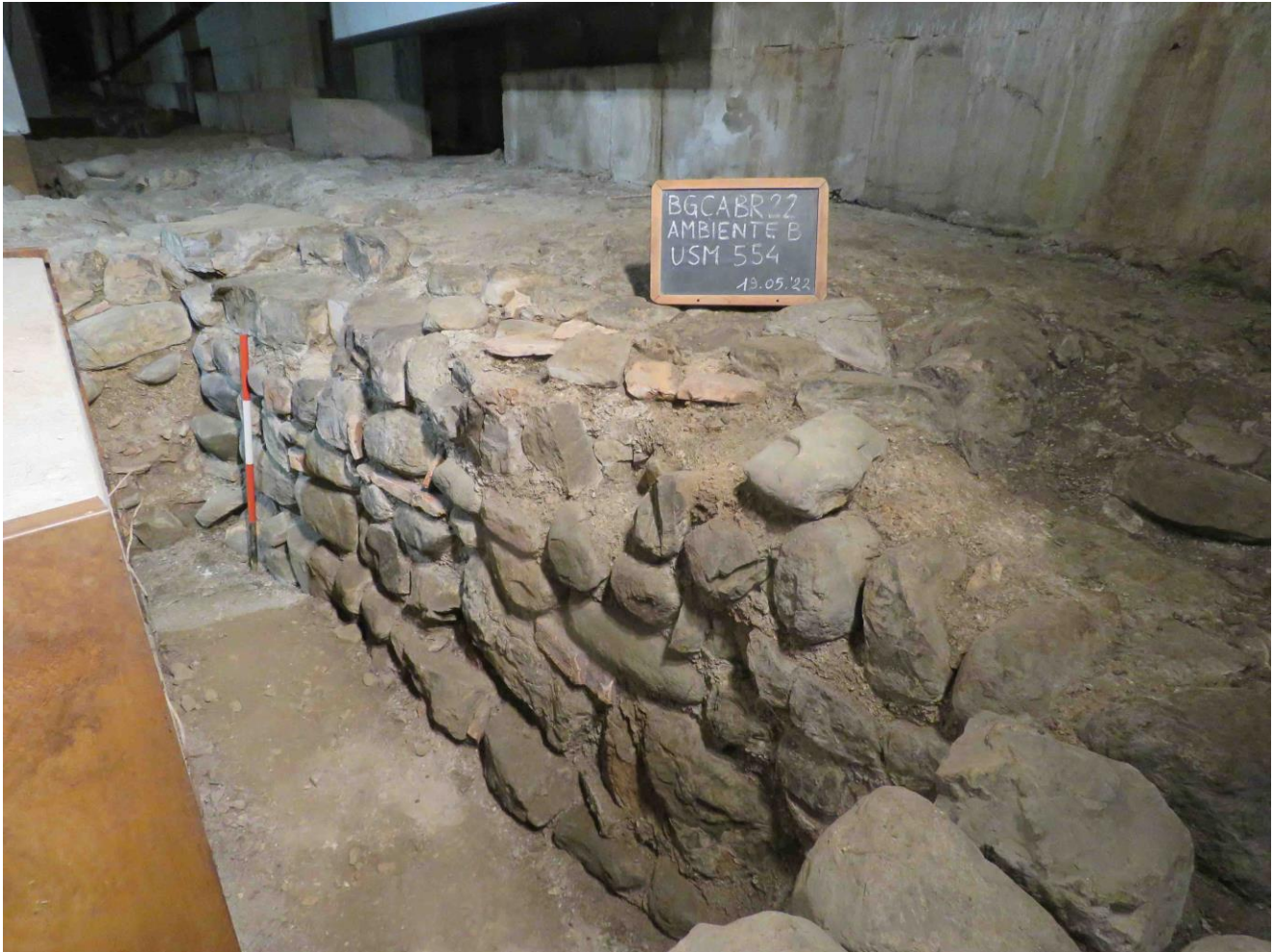
Fig. 19. Vano B, perimetrale nord (554).
