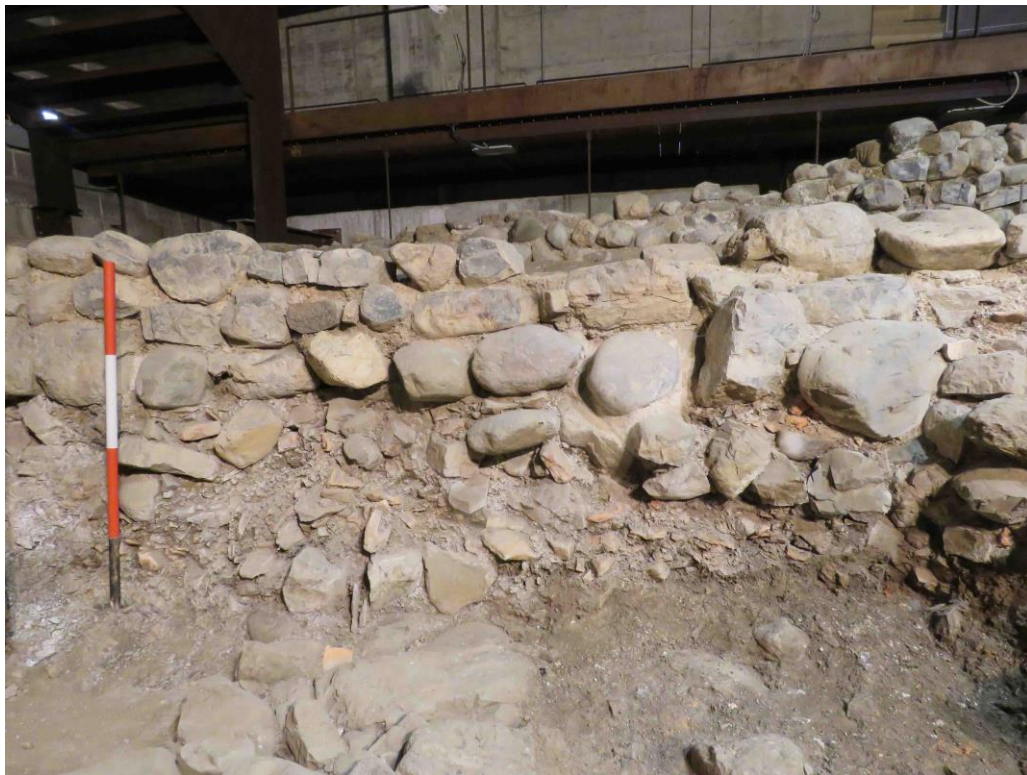
Fig. 21. Vano B, sezione del deposito stratigrafico con il crollo delle murature (1106).
