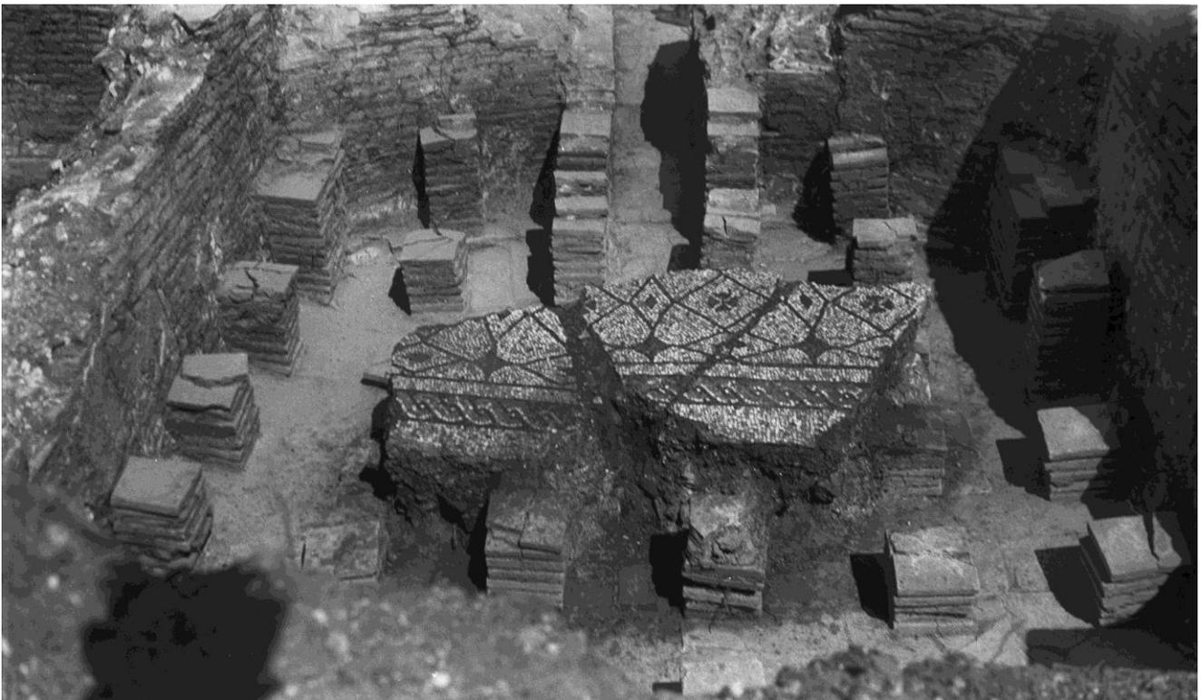
Fig. 20. Ripresa da O a E del calidarium 13 con le suspensurae e una parte del mosaico pavimentale in posizione di crollo. Nella parte superiore è evidente l'abside con la connessione al praefurnium 12. AFCA 3764 (su concessione del MiC – SABAP di Cagliari).
