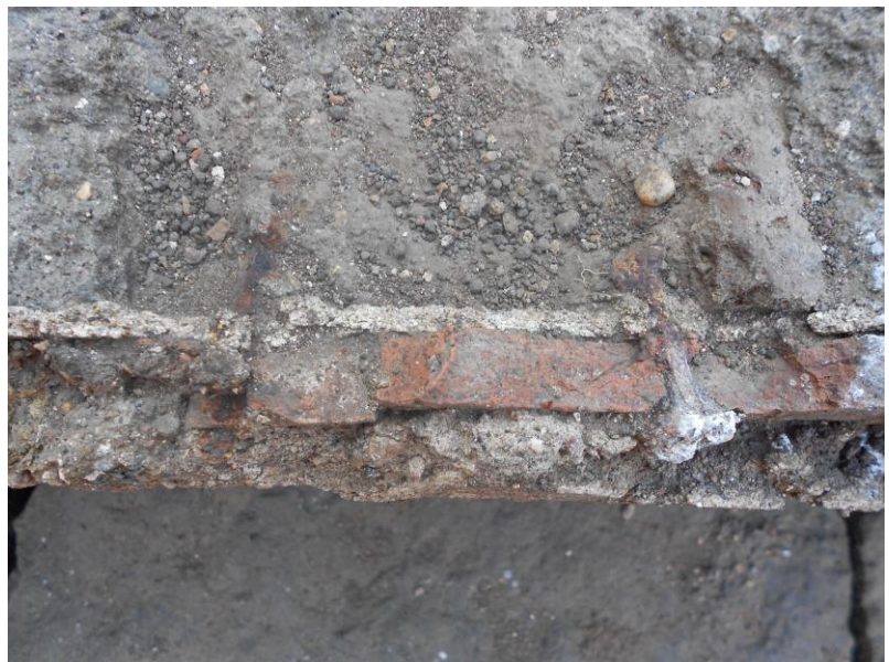
Fig. 7. Dettaglio del sistema di messa in opera della decorazione a intonaco 2135.
