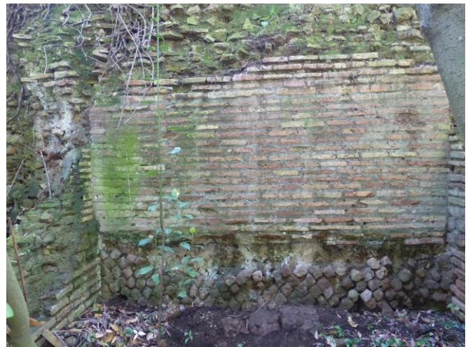
Fig. 7. Tronçon de la muraille situé au sud de la Porta Secundaria. Reconstruction de la partie supérieure en opus testaceum et adossement d'un nouvel édifice (vue de l'est). Cliché personnel. État en mai 2019.
