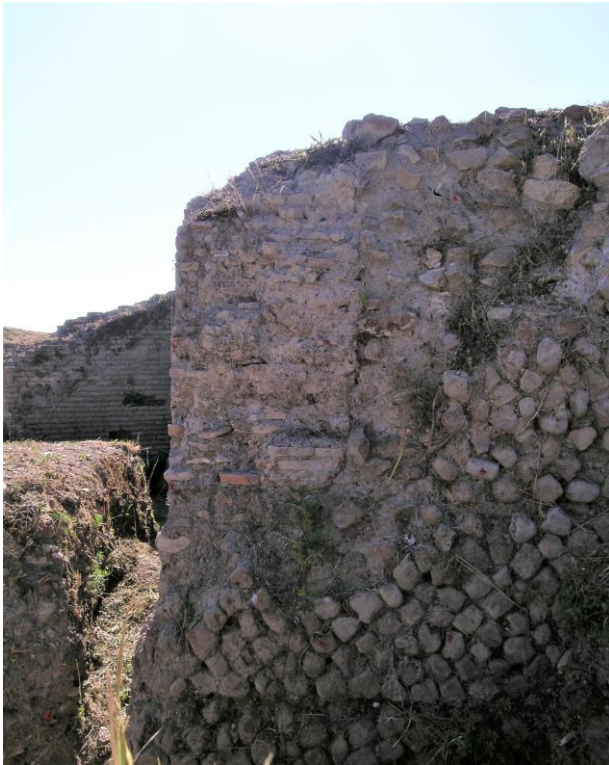
Fig. 6. Poterne, détail du jambage droit en opus testaceum (vue de l'est). Cliché EFR, 2006.
