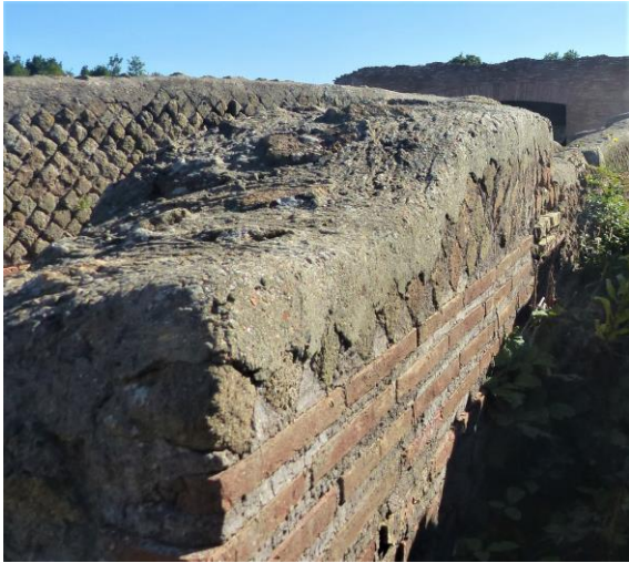
Fig. 8. Tronçon de la muraille situé à l'ouest de la Porta Marina. Détail de la restauration en opus mixtum à panneaux (vue de l'ouest).
