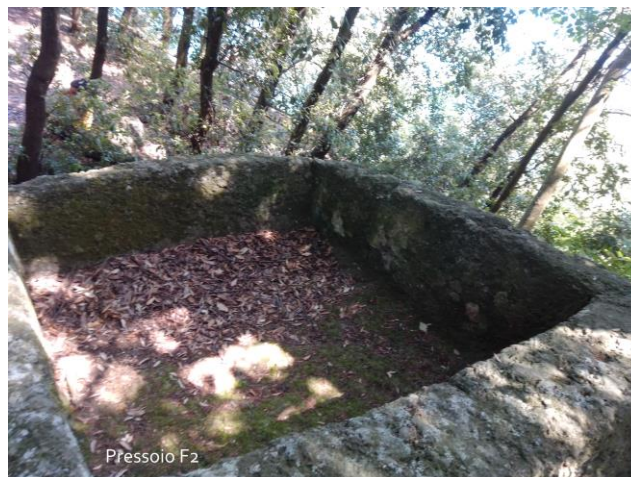
Fig. 17. Interno della vasca del palmento F2.
