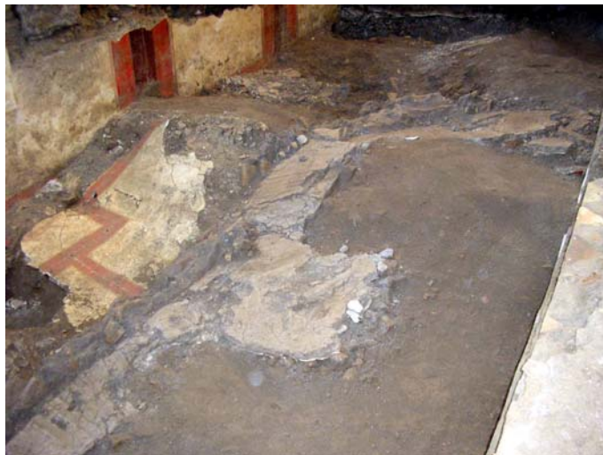
Fig. 4. Crollo delle pareti e del soffitto del corridoio
