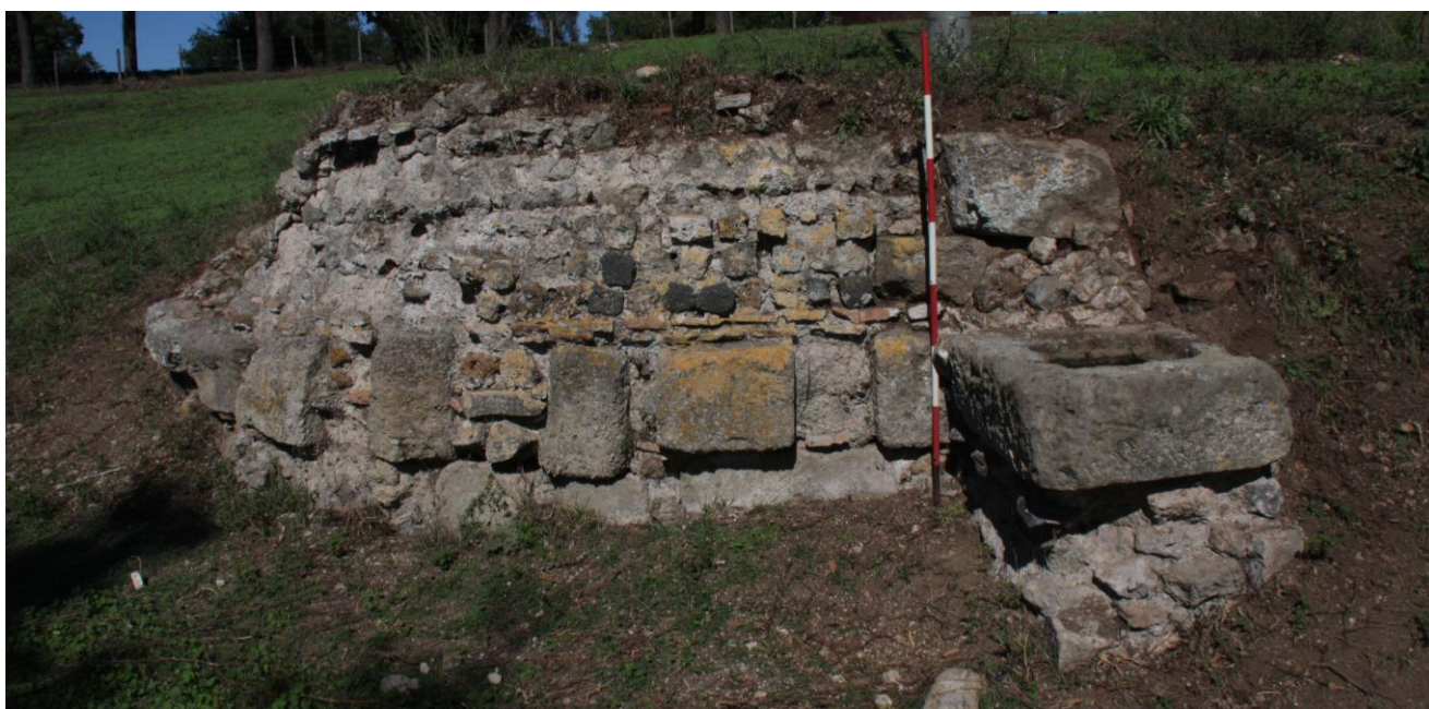
Fig. 15: Chiesa di San Bonifacio, abside meridionale, veduta da Sud-Ovest
