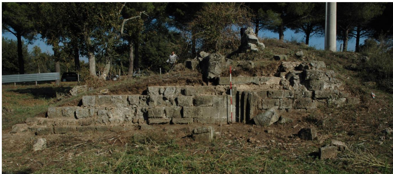
Fig. 16: Chiesa di San Bonifacio, muro perimetrale Nord, veduta da Sud
