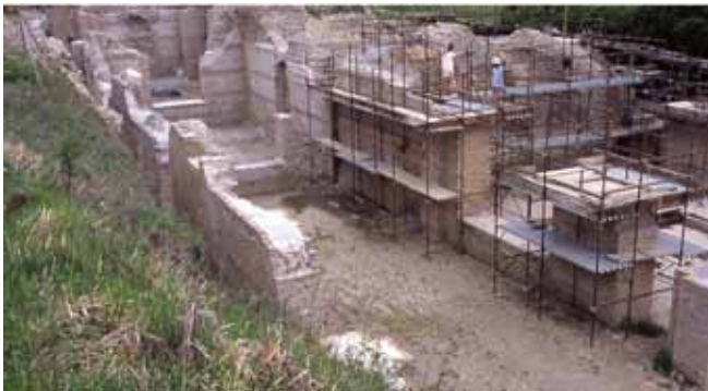
Fig. 6. Gli ambienti monumentali Ovest in corso di restauro.
