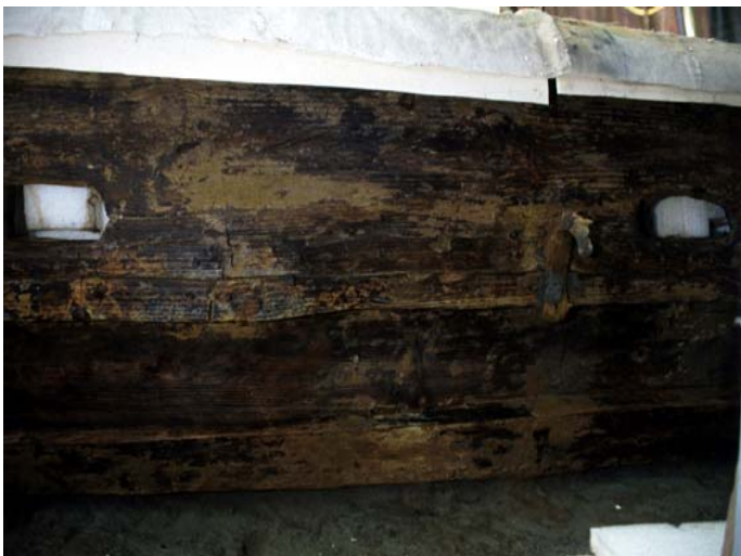
Fig. 5. Particolare della fiancata della Nave C
