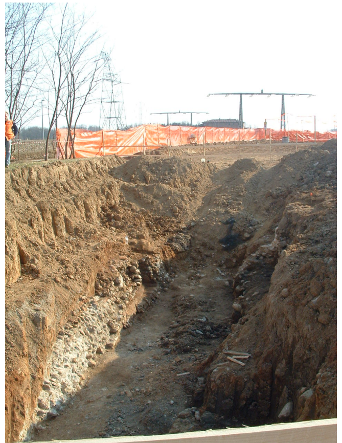
Fig. 1. I resti della cisterna nella trincea del collettore al momento dell'intervento.
