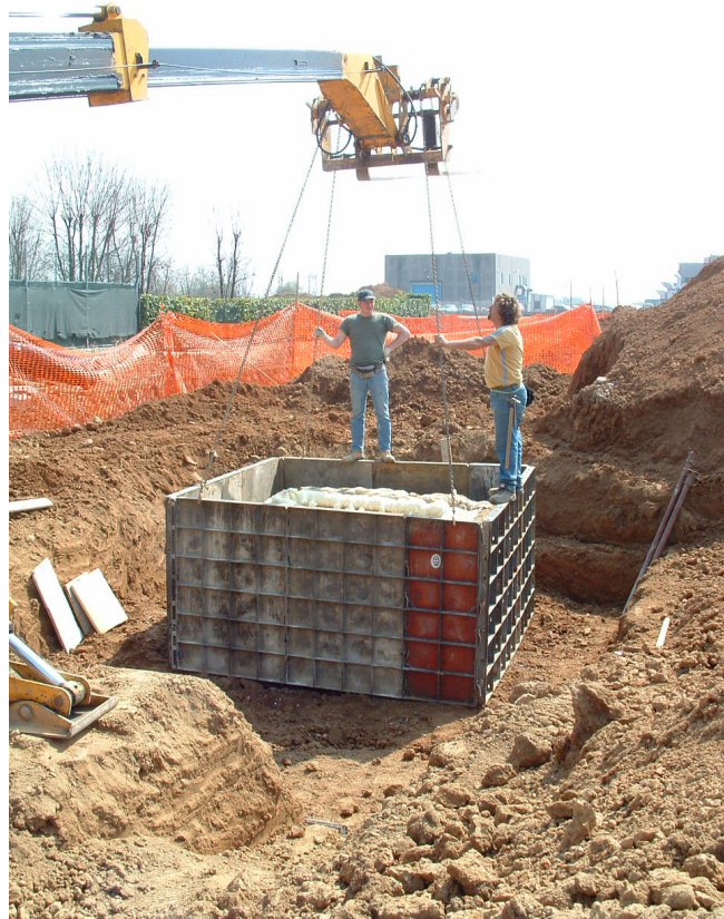
Fig. 16. Recupero della struttura della tomba 3.
