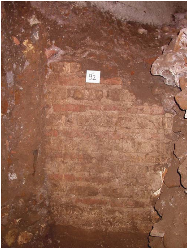
Fig. 4. Ambiente C: particolare della USM 92 in opus vittatum, indobata parzialmente nel nicchione rinascimentale (a destra).
