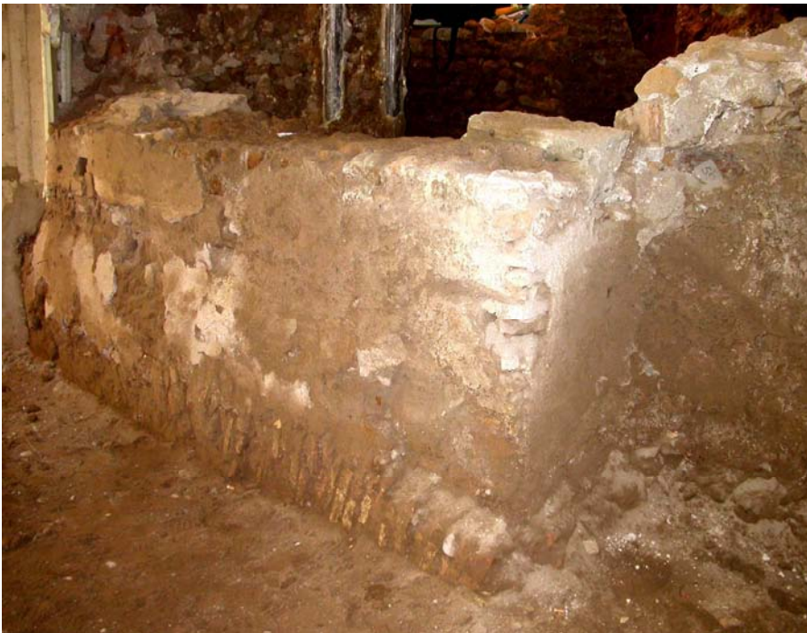
Fig. 11. Il muraglione rinascimentale con sottoposto arco ribassato.
