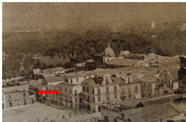
Fig. 19. P.zza Mercato in una foto degli inizi del '900. Indicata dalla freccia una porzione allora visibile della struttura muraria (6) riportata alla luce dallo scavo.
