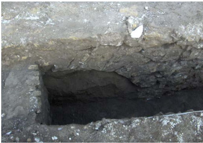
Fig. 5. Una delle arcate di fondazione della struttura 6.
