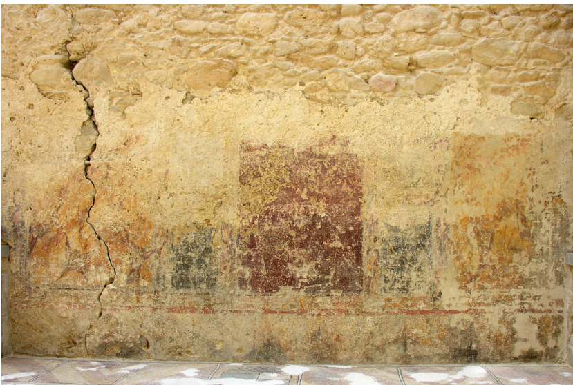
Fig. 17. Palestra delle Terme, pitture ad imitazione di crustae marmoree (foto: E. Gasparini).
