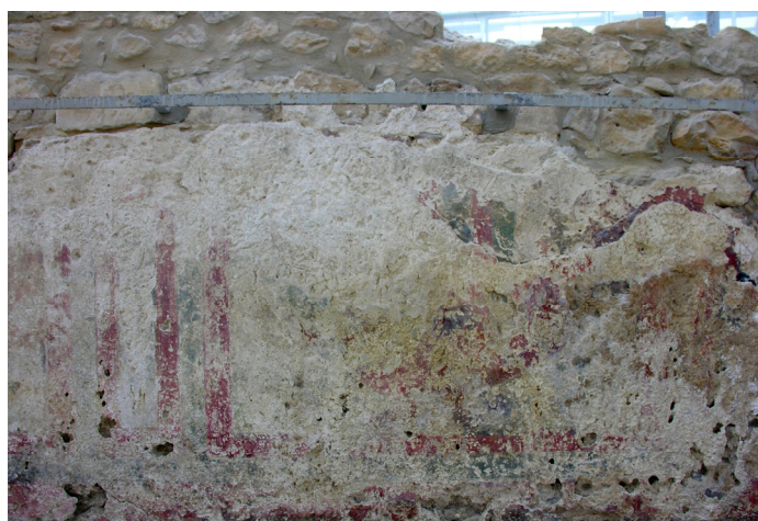
Fig. 19. Particolare delle due fasi di pitture sovrapposte presso l'ambulacro meridionale del Peristilio (foto: E. Gasparini).
