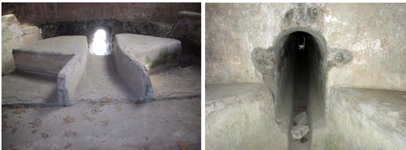
Figg. 12-13. A sinistra fondo del castellum aquae, a destra parete interna del castellum aquae di Pompei (foto S. Sakai).
