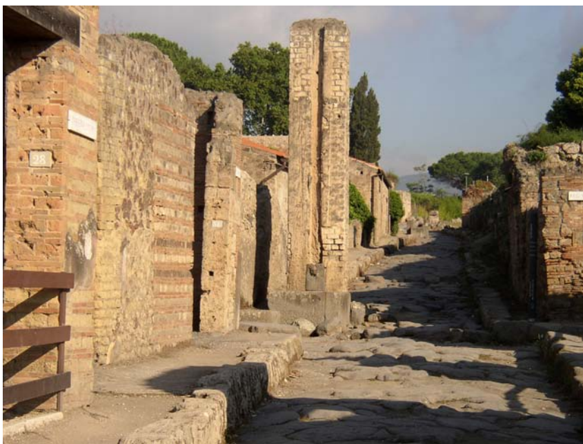
Fig. 5. Uno dei pilastri per il "troppo pieno" nell'area archeologica di Pompei (foto S. Sakai).
