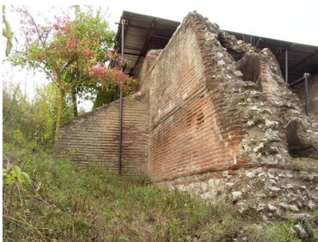
Fig. 15. Resti dell'acquedotto in Loc. Torone (Palma Campania, NA) (foto S. Sakai).
