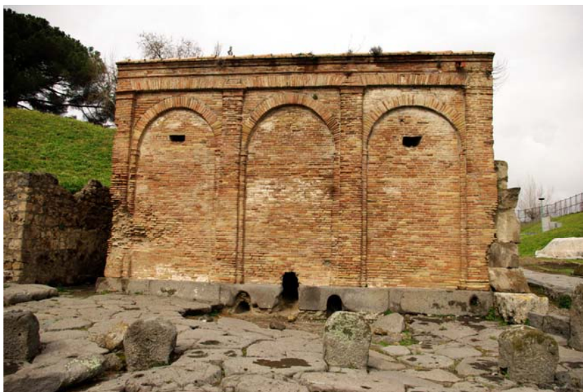
Fig. 4. Il castellum aquae di Pompei (foto S. Sakai).
