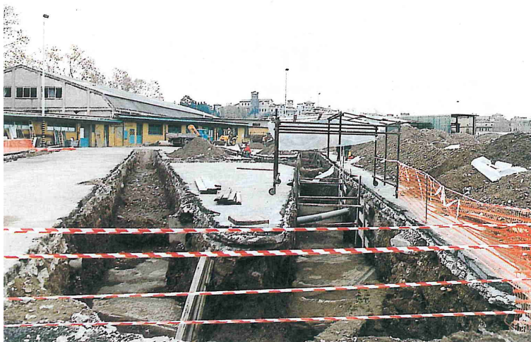
Fig. 2. Trincee esplorative all'interno del cortile del deposito ATAC.
