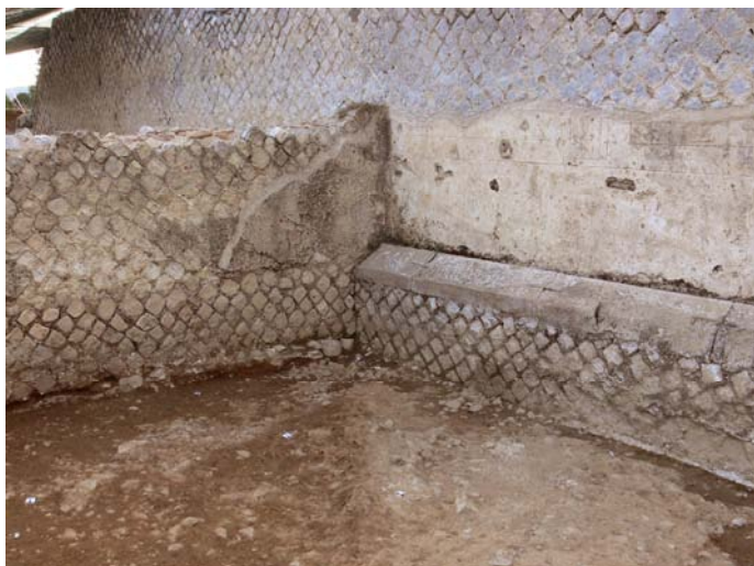
Fig. 23-24. Settore ad Est del Tempio C. Ambiente D: il muro di fondo del portico si addossa alla parete orientale del Tempio C (a sinistra) e ambiente A: muro interno della scala che si addossa al muro esterno del portico (a destra).
