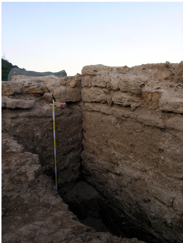
Fig. 2. Paramento esterno della muratura di fondazione dell'abside e del contiguo ambiente H.
