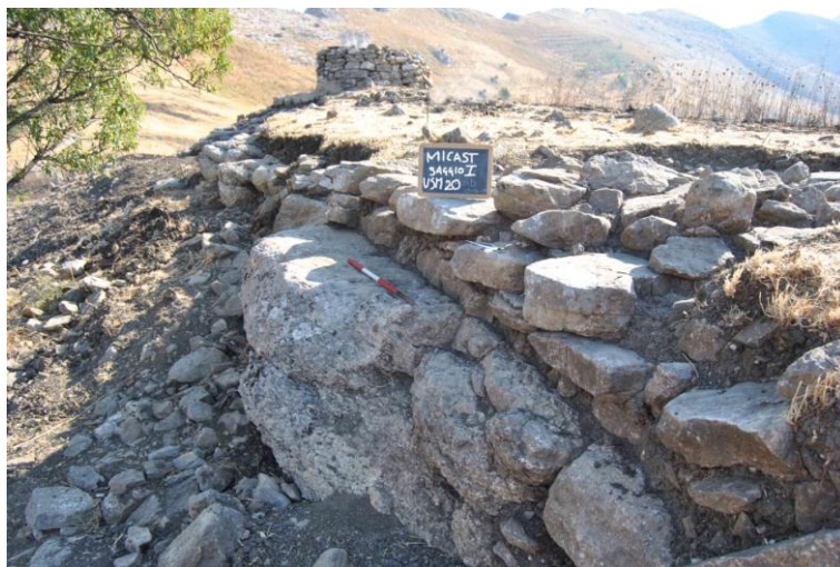
Fig. 10. Cinta muraria (20) che si innesta direttamente sul banco roccioso (Antonio Alfano).
