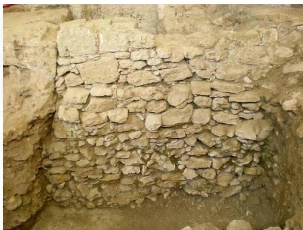
Fig. 20. Fondazione muraria che delimita a sud-ovest il vano I (v. fig. 9).
