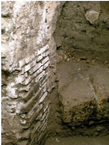
Fig. 13. Struttura in mattoni e tegole.
