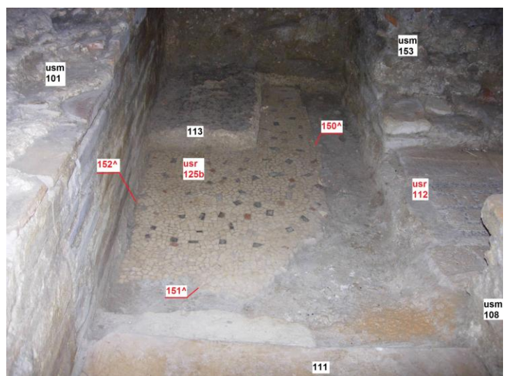
Fig. 15. Domus, vano B, le strutture murarie di II fase 108 e 153 vengono fondate tagliando il vecchio piano di I fase 125b, a sua volta usato per impostare la preparazione 113 del nuovo piano 118. Sulla destra si osserva il setto 101 di IV fase che, privo di risega, produce un taglio dei piani a filo con la parete.
