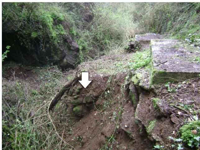
Fig. 4. Ninfeo Rosa: muro in blocchi tufacei sezionato dalla canalizzazione del Fosso dei Cappuccini.
