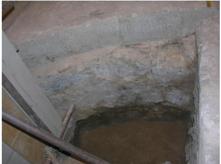
Fig. 15. Particolare dell'abside e della risega.
