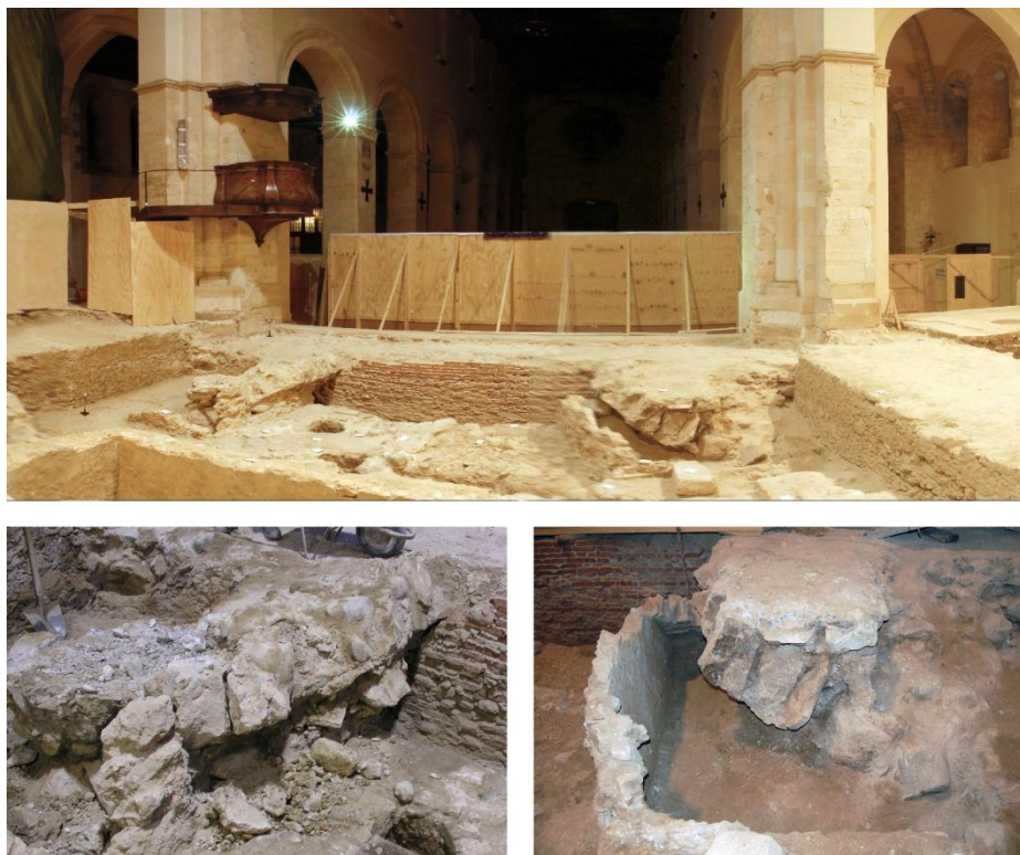
Fig. 26. Innalzamento del piano del presbiterio e delle navate con voltine in muratura.
