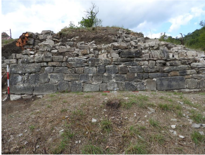
Fig. 7. Area 1000, parte terminale dell'abside (101) ascrivibile all'ultimo restauro della chiesa.
