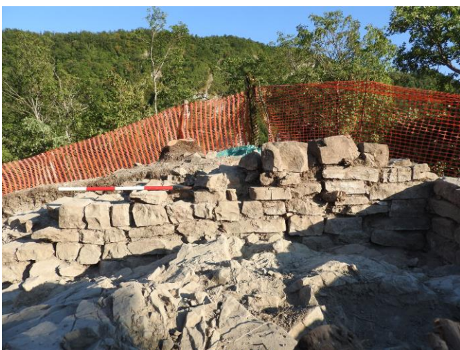
Fig. 12. Area 3000, Settore Omega, paramento interno di un perimetrale (301) della torre, che risulta più irregolare a causa delle radici di alcuni alberi.
