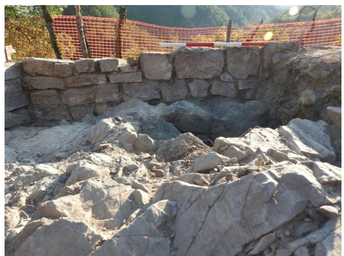
Fig. 13. Area 3000, Settore Omega, paramento interno di un perimetrale (301) della torre, dove è visibile lo sdoppiamento dei giunti.
