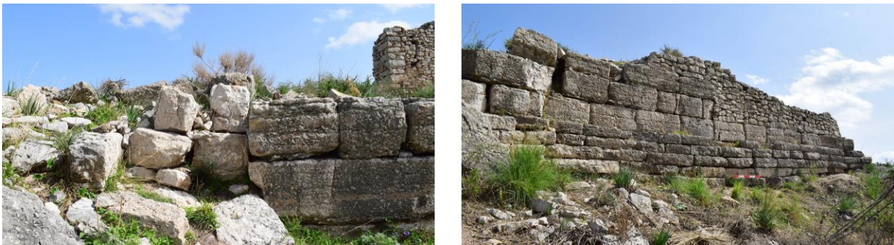
Fig. 7. Veduta del muro di fortificazione occidentale – a destra la parte meridionale con la base scalonata, a sinistra il particolare del blocco d'angolo.
