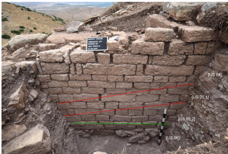
Fig. 20. Veduta della parete interna del muro settentrionale della postazione per artiglieria all'interno del saggio n°2.
