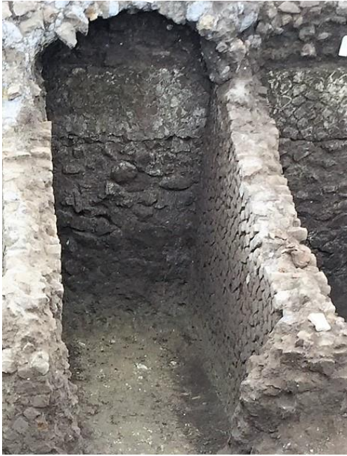
Fig. 7. Foto dell'interno di una delle cellette dell'ambiente V dove si possono notare le tracce della centina e della malta (foto progetto Immensa Aequora).
