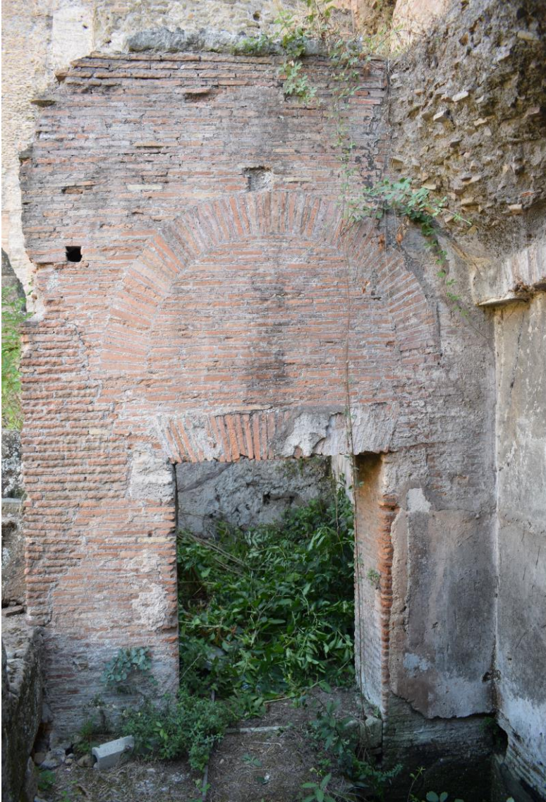
Fig. 16. Amb. VIII, muro 14, particolare dell'ingresso al vano VII.
