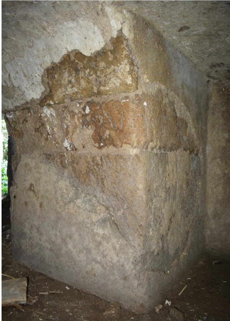
Fig. 7. Amb. IV, muro 3, particolare delle ghiera in opera quadrata.
