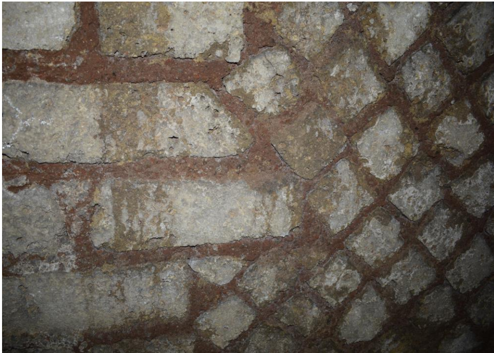
Fig. 14. Amb. I, muro 11, particolare dell'opus reticulatum.
