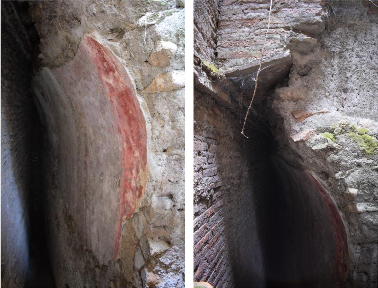
Fig. 11. Amb. I, muro 9, particolare dell'intonaco sulla cortina occidentale e della volta crollata con sarcitura antica successiva.
